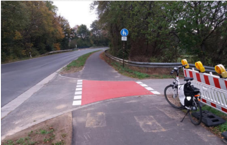
Soerser Weg (Abschnitt 3) Bestand: außerorts, separater Geh- und Radweg In 2018 saniert
